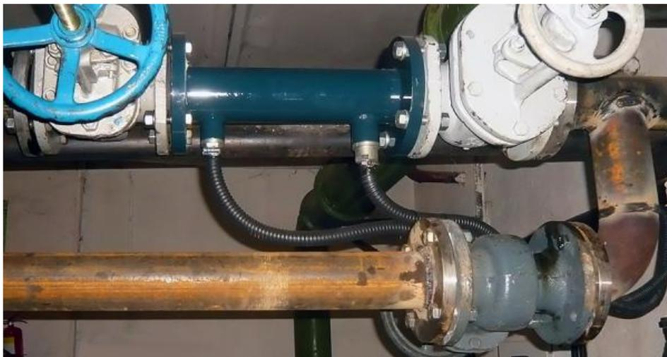
Влагомеры жидких материалов эксплуатируются в котельных в системах дозирования воды и диспергирования водомазутной эмульсии. Для управления клапанами, регулирующими подачу воды, в состав поставки может быть включен шкаф управления.
